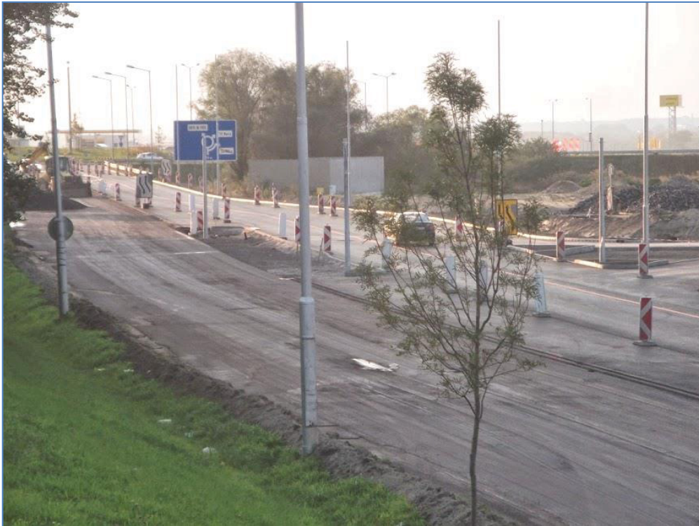
Obr.5 Budovanie cestných objektov po častiach a za premávky
